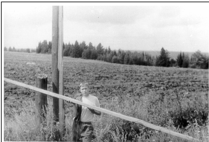
Рис. 4.10. От наиболее сильно пострадавшей опоры N 6 (рис.4.9) отколота щепа
