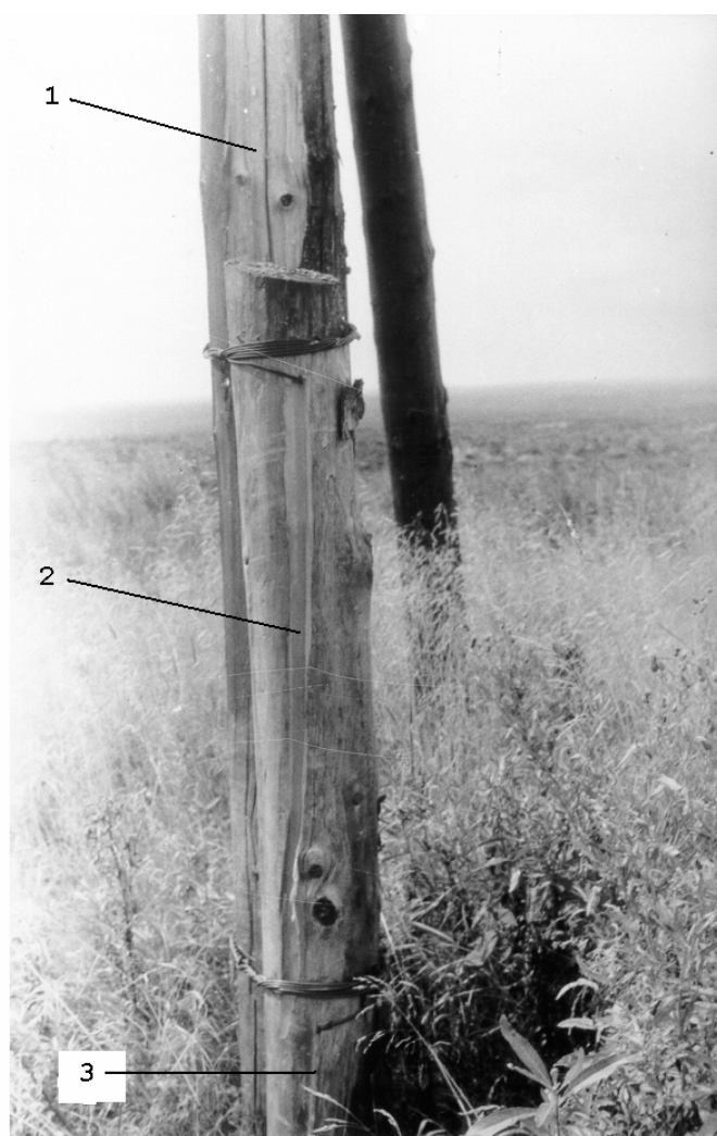
Рис. 4.11. Характерные сколы щеп от металлических аксессуаров опоры N 4 (рис.4.9)
