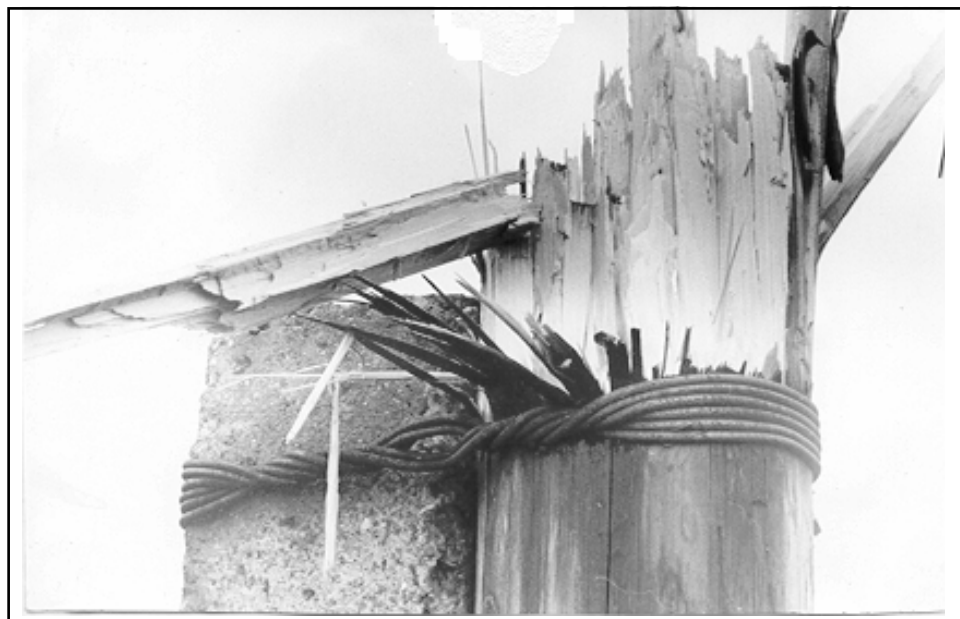
Рис. 4.6. Наиболее сильно разрушенная молнией (до бандаж) опора линии электропередачи в Глазовском районе (фото Ешметьева А.С.)
